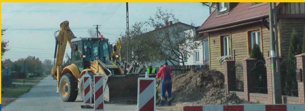
Budowa kanalizacji sanitarnej w Chrząchowie gm. Końskowola
