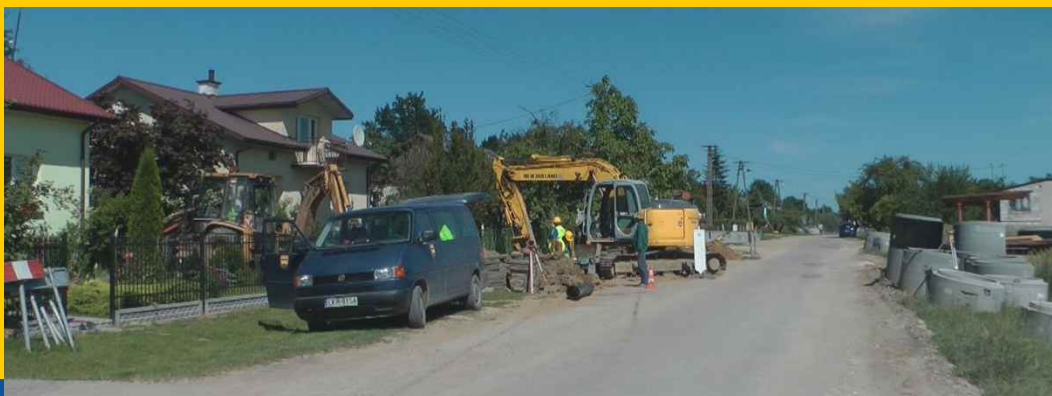
Budowa sieci kanalizacji sanitarnej w Woli Osińskiej gm. Żyrzyn
